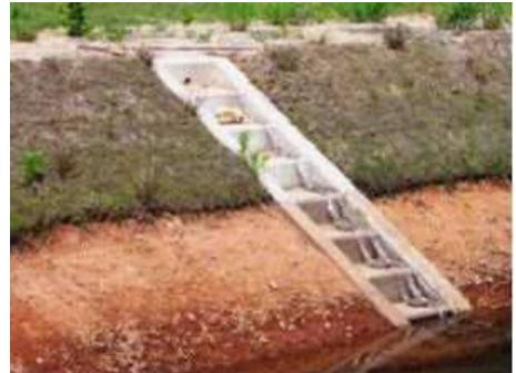
斜樋と取水栓（コンクリート製品）
