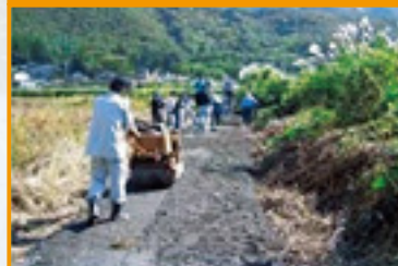
アスファルト舗装の補修
