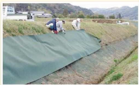
法面に防草シートを敷設
