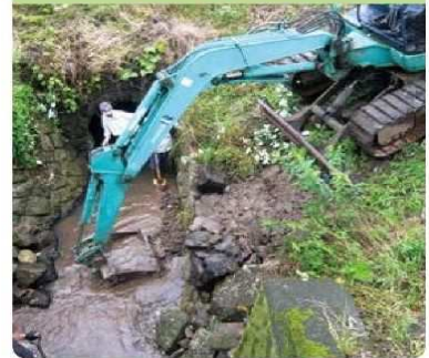
異常気象等後の応急措置
