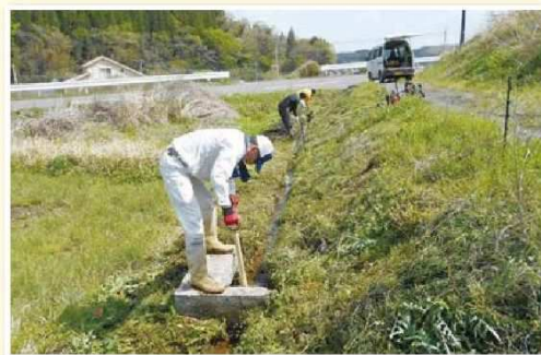
水路の泥上げ▶
