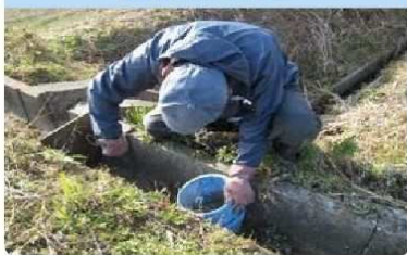
水路の目地補修
