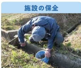
水路の目地補修
