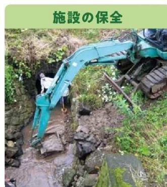
異常気象等後の応急措置
