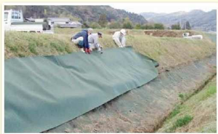
法面に防草シートを敷設
